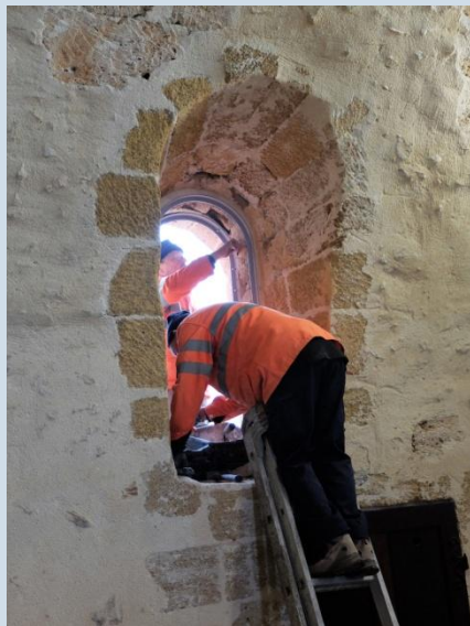
Réfection des appuis et de l'espace entre les deux cadres
