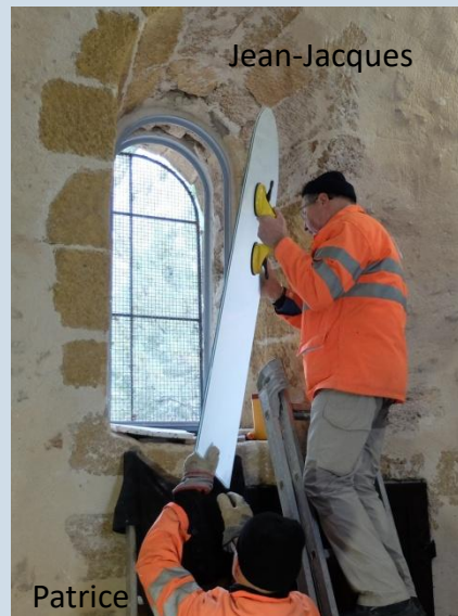
Injection du joint silicone puis placement de la vitre
