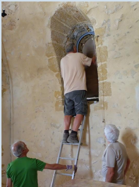
Août 2017, essai réussi des cadres (Châssis dormants)
