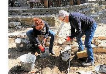
On commence par "décaisser", le sol (ôter pierres et terre) sur 30 cm de profondeur, à la pioche
