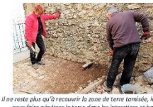
Il ne reste plus qu'à recouvrir la zone de terre tassée, la broser pour faire pénétrer la terre dans les interstices et balayer
