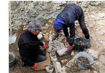
On place les pierres de chant en les serrant les unes aux autres dans la terre. Quelques pierres sont enfoncées profondément dans la terre ("bottasse").
