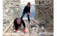
Puis on pose les "conducteurs", grosses pierres qui donnent le sens d'écoulement des eaux de ruissellement, la terre tassée sert d'assise et de liant.
