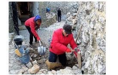
On "dôme" alors avec un morceau de madrier de façon à mettre les pierres de niveau avec les autres
