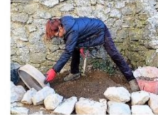
La provision de terre tassée est à proximité
