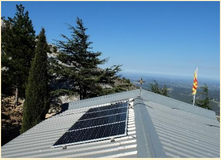
Les panneaux solaires seront déplacés lors des travaux de toitures
