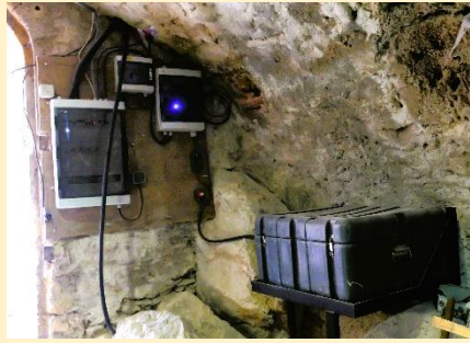
Le tableau électrique, l'onduleur et les batteries dans la cave
