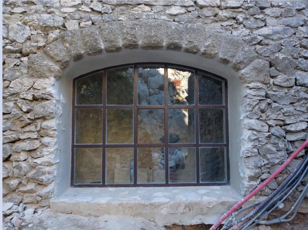
Octobre 2017, la baie est munie d'un caroyage en acier laqué et de verre clair feuilleté antieffraction. Reprise des voussures et de l'appui de la fenêtre en maçonnerie
