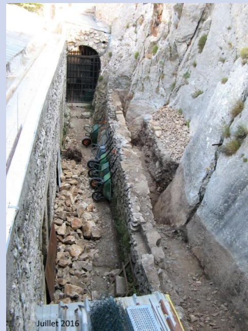
Juillet 2016, la tranchée est presque achevée
