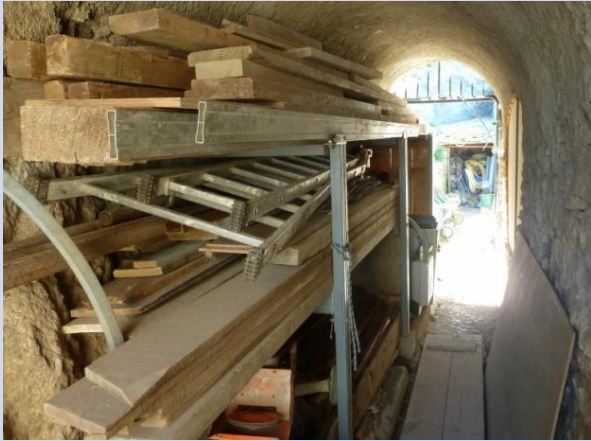
2013, avant les travaux, elle est une remise à matériaux, la grande baie est occultée
