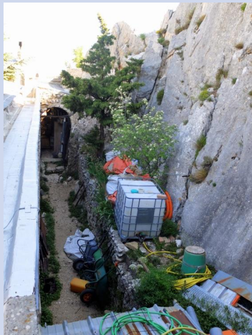
2015, avant les travaux
