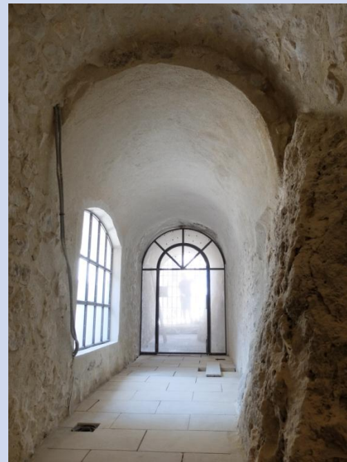
12 octobre 2017, la menuiserie de la baie en anse de panier et la porte intérieure sont installées
