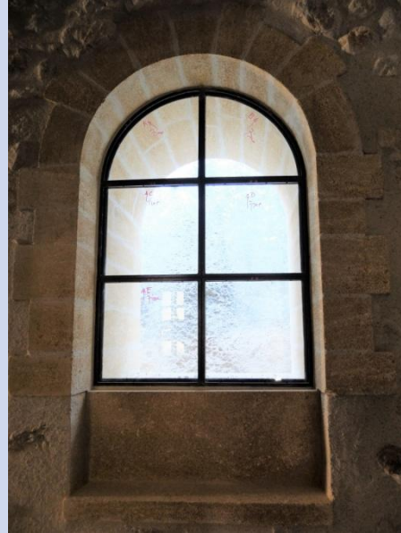
Une des deux baies voûtées en plein cintre. Début octobre, pose de joints au mortier de chaux
