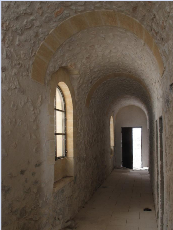
26 octobre 2017, vue partielle vers le sud
