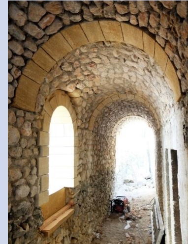
16/02/2017, voûte non enduite, vue vers le sud
