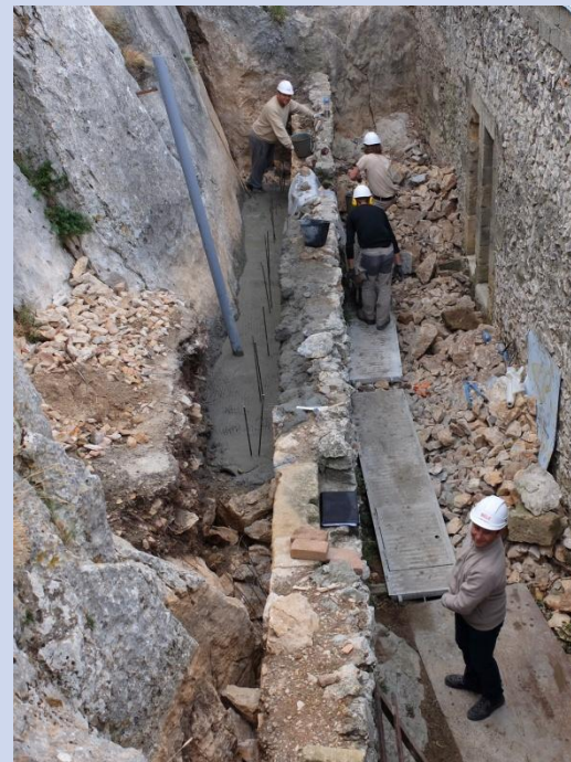
6 octobre, début des fondations du mur de doublage
