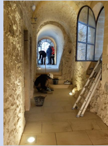
Novembre 2017, Finition des sol (joints au mortier) et installation de l'éclairage
