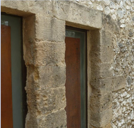
2 des 4 baies avant les travaux. Elles sont en verre dépoli et partiellement occultées
