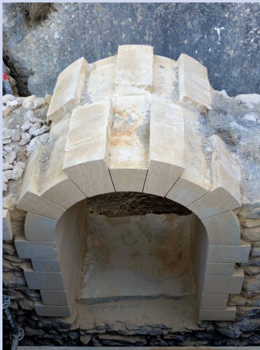
12 janvier 2017, une des deux fenêtres, jambages et voûtes réalisés en pierre de Vers, taillées sur place
