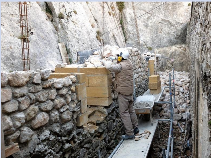
10 novembre 2016, maçonnerie des jambages des 2 fenêtres, au mortier de chaux
