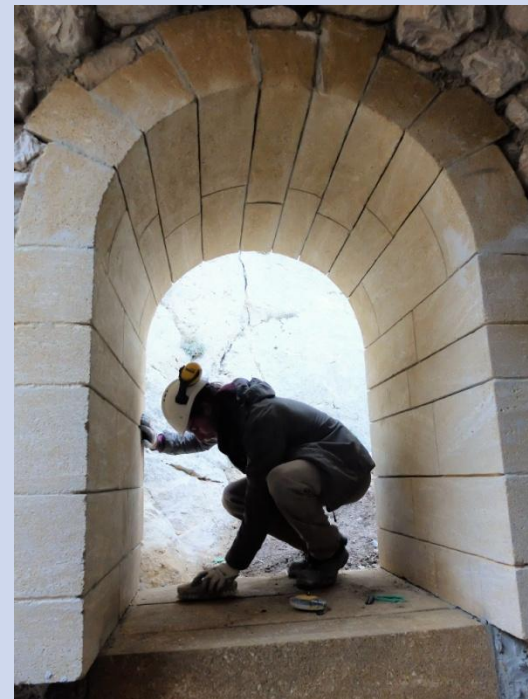
2 février 2017, finition de l'appui d'une fenêtre
