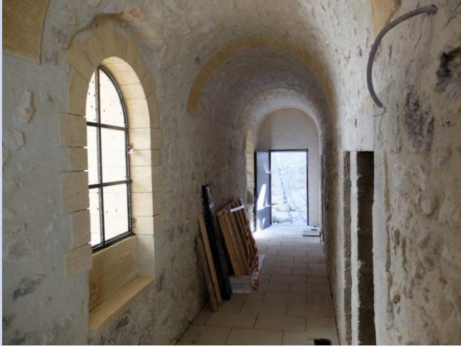
Vue vers le sud, avec installation de la porte en acier laqué, donnant au fond sur la remise non achevée.
