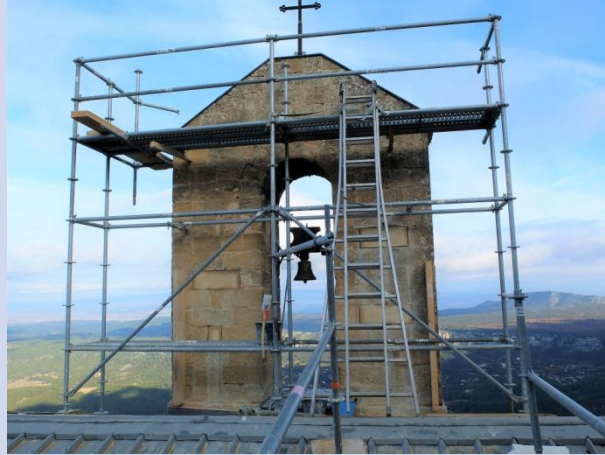
5 pierres dégradées ont été remplacées
