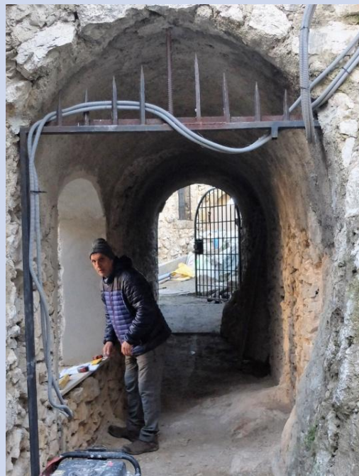
Octobre 2016, l'espace est dégagé, la baie en anse de panier a été désobstruée.
