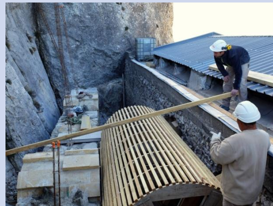
Autre vue du coffrage installé
