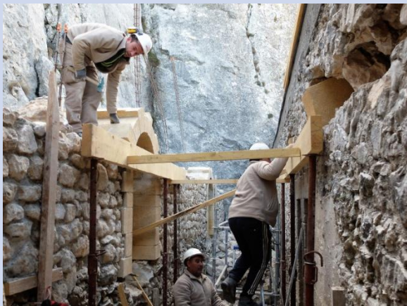
8 décembre 2016 échafaudage avant l'installation du coffrage de la voûte
