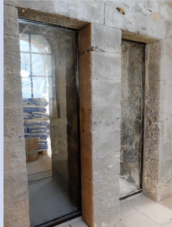
Fin septembre 2017, remplacement par des verres clairs feuilletés. Une des 4 baies est ouvrante
