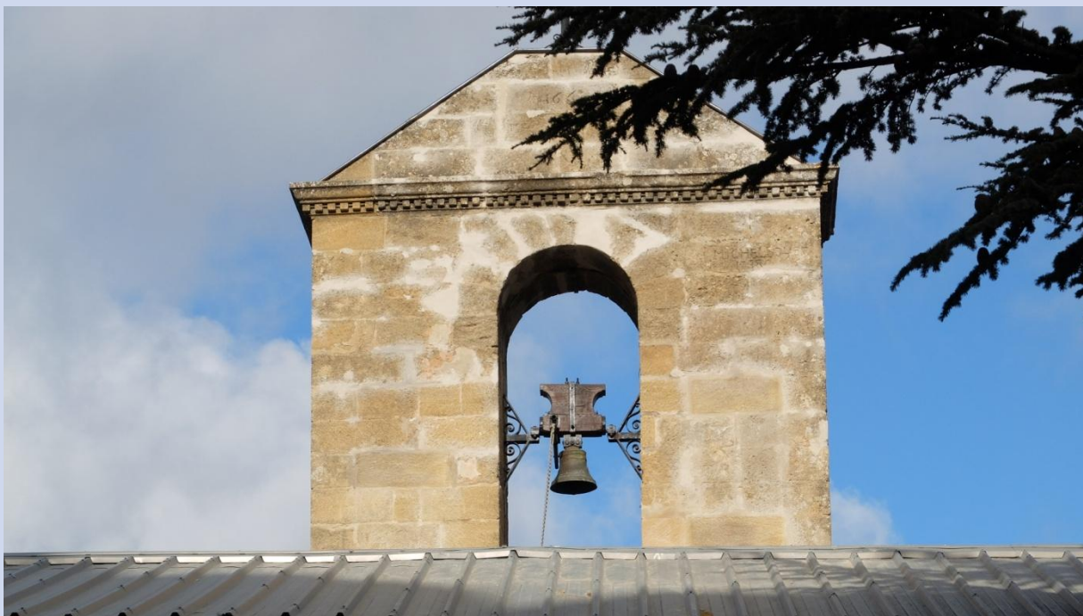
Décembre 2017, le clocher rénové
