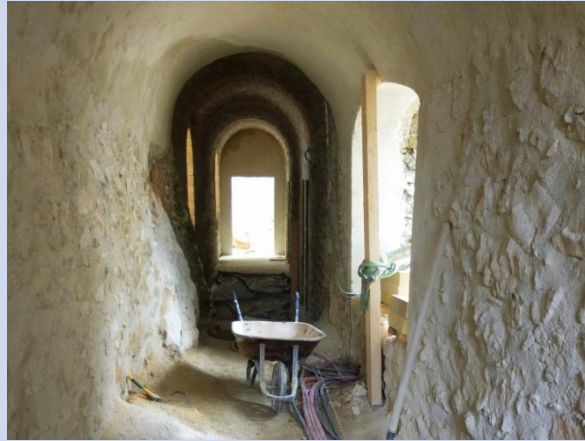
Fin avril 2017, baie désobstruée, voûte enduite
