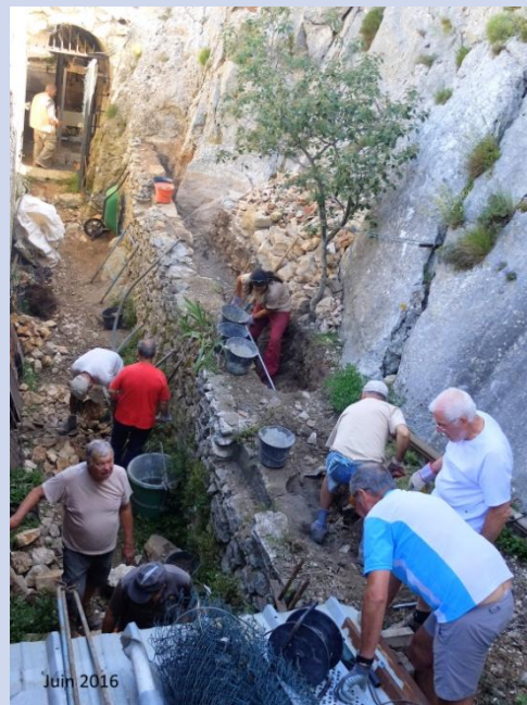
Juin 2016, creusement de la tranchée
