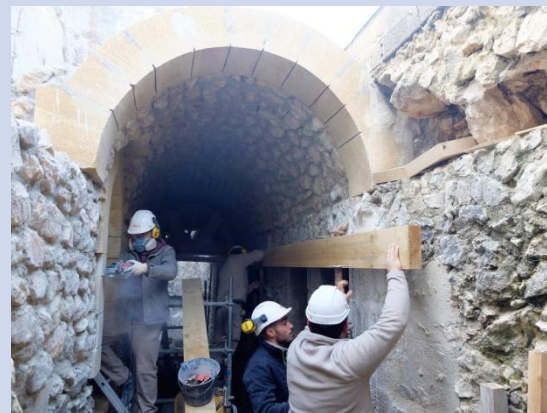
2 février 2017, le coffrage va être déplacé pour la troisième fois
