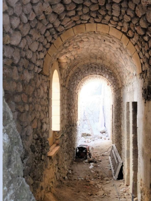
février 2017, intérieur de la voûte en cours de travaux
