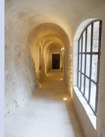
Novembre 2017, Finition des sol (joints au mortier) et installation de l'éclairage
