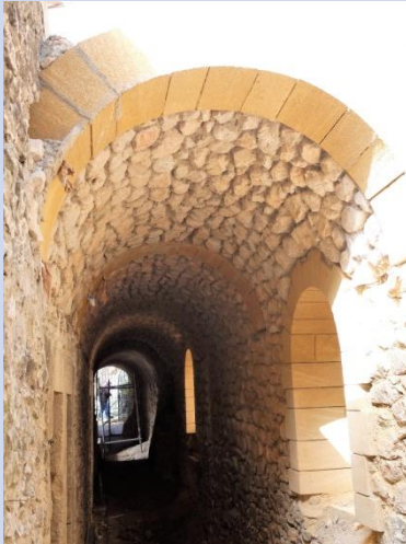
16/02/2017, voûte non enduite, vue vers le nord
