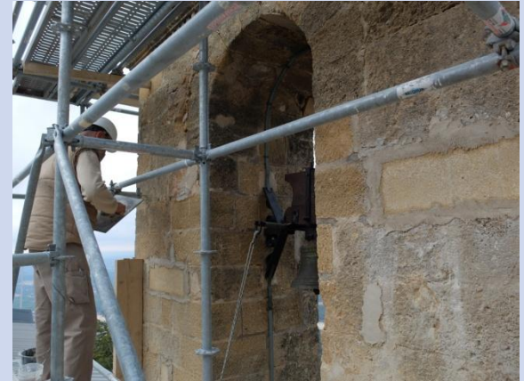
Jointoiment des pierres et reprise des joints détériorés.
