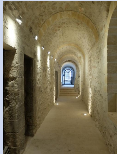
Décembre 2017, les travaux sont achevés
