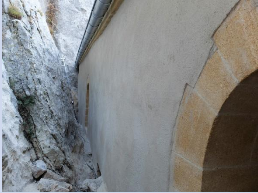
Le mur est, contre la falaise, est enduit
