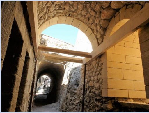
12/01/2017 premier tronçon de la voûte, vue vers le nord
