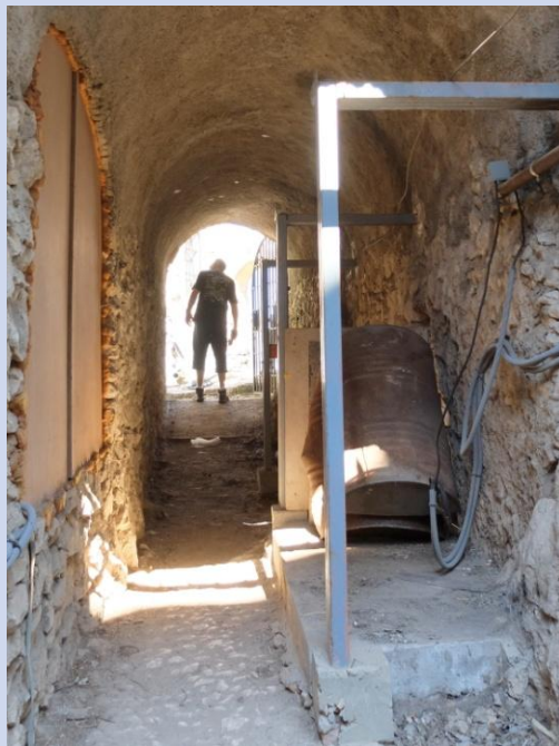
Été 2016, les étagères sont en cours de démantèlement pour dégager le couloir
