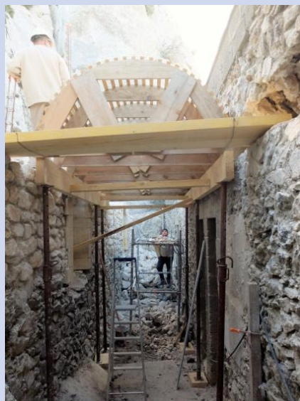
Même jour , le coffrage est installé
