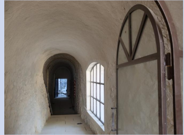
Octobre 2017, menuiseries posées, sol dallé presque achevé
