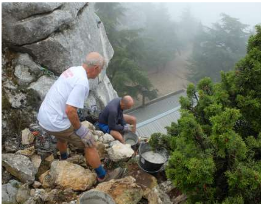
Confection d'un muret près de la faille de la falaise
