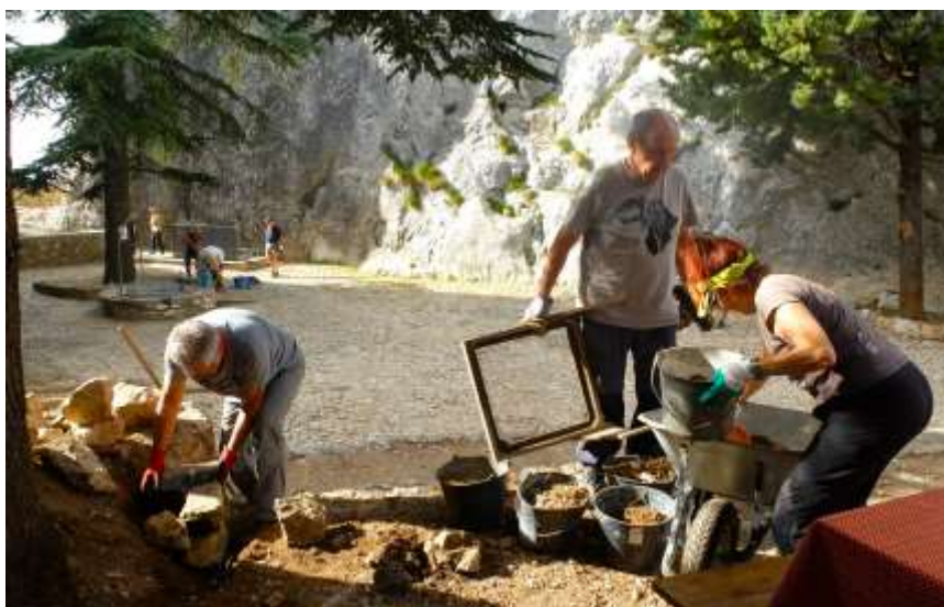
Confection d'un muret devant le Logis
