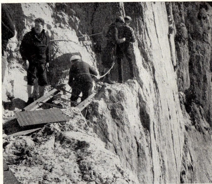
Travaux : Les "Amis de Sainte-Victoire" sur la brèche... des Moines, lors de l'aménagement du seuil (18-10-64)
