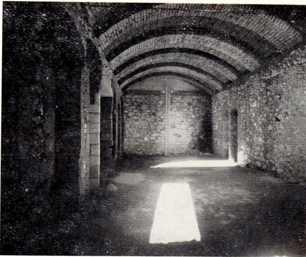
Après restauration (1965). L'intérieur du Monastère. Au fond mur N. reconstruit et voûte-toiture. À gauche mur de façade. À droite portes de sortie des Cellules. (Photo M. BARES)
