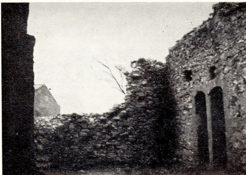
Avant reconstruction (1958). Le mur N du Monastère vu de l'intérieur (?) du bâtiment... Au fond, à gauche mur du chevet de la Chapelle. A droite portes de sortie des cellules Nord donnant dans le Cloître.
