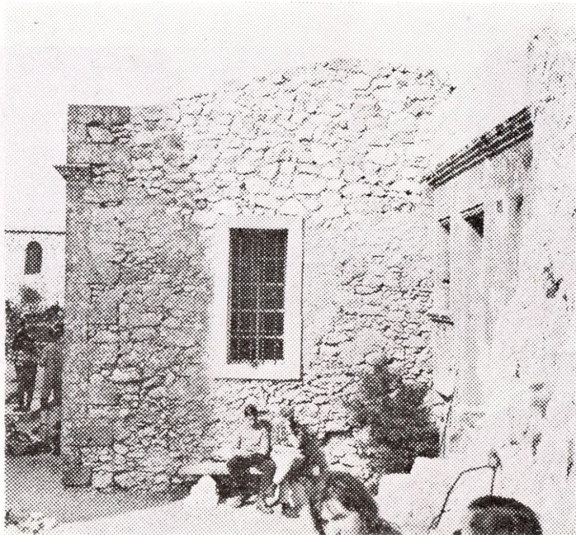
après reconstruction et percement d'une fenêtre en février 1968.
