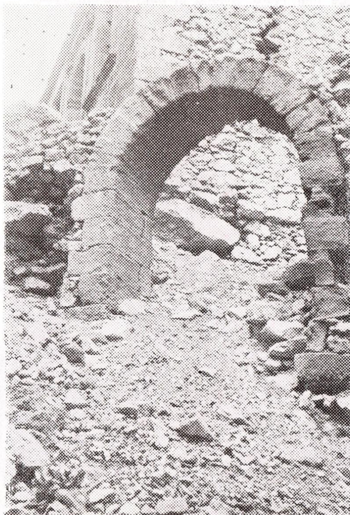
Arceau vers la brèche en 1957...
