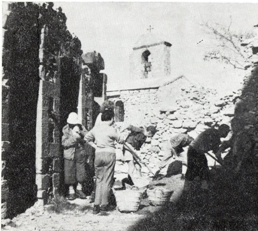
Déblaiement de l'intérieur (?) du Monastère (1962)
