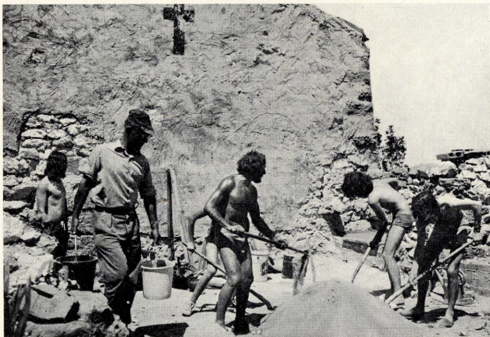
Début des travaux de reconstruction du Logis, au fond le mur de de chevet de la Chapelle à droite : mur Nord
