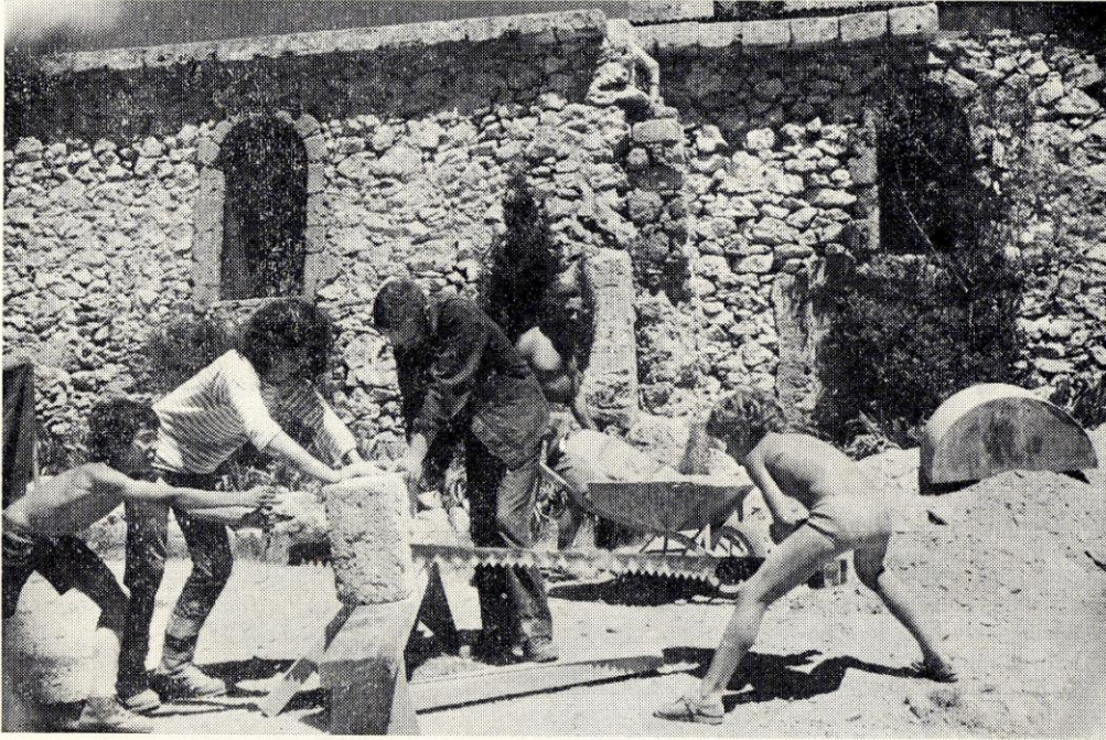
Sciage des pierres tri-séculaires en vue de leur nouvelle utilisation
