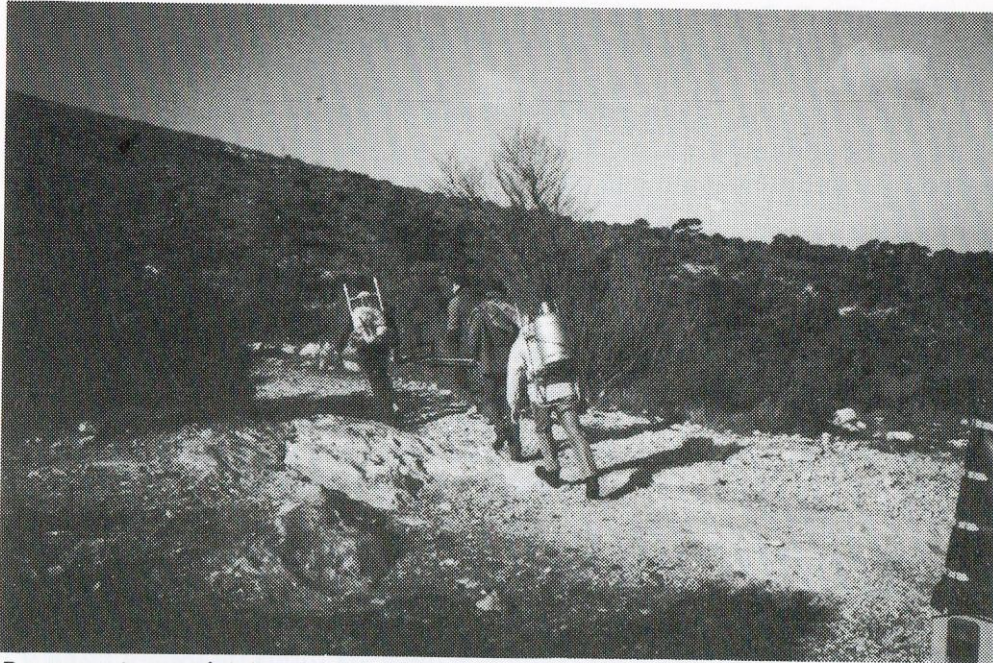
Portage du matériel pour les travaux
