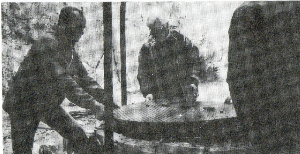
Réfection du puits et de la pompe. (Ph. S. Revalor).
