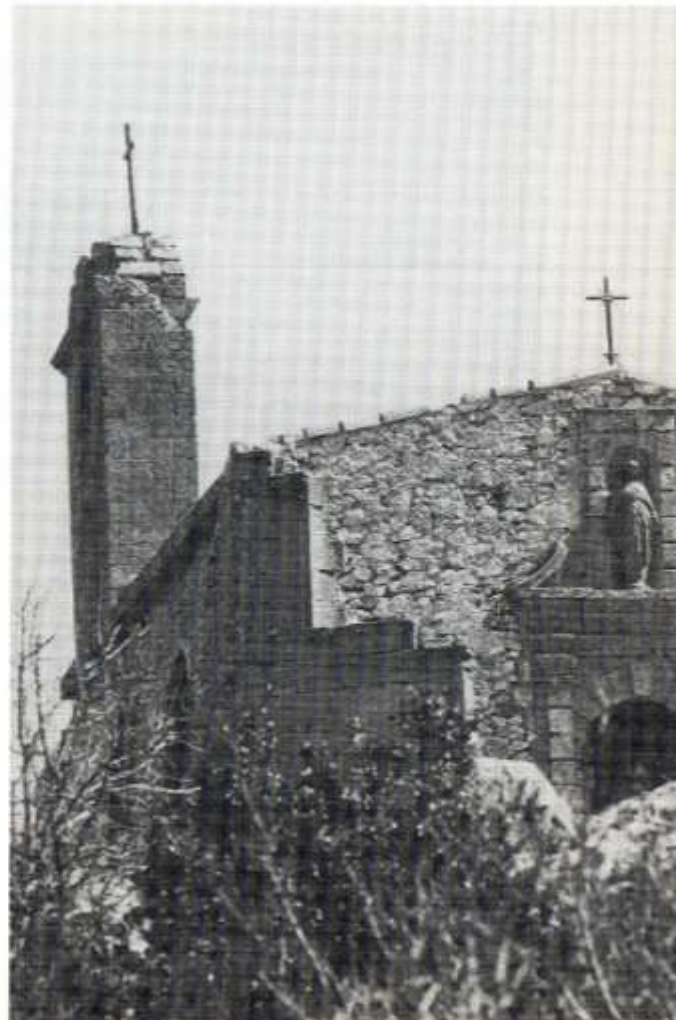
La statue dans sa niche au-dessus de l'entrée (photo S. Revalor)
