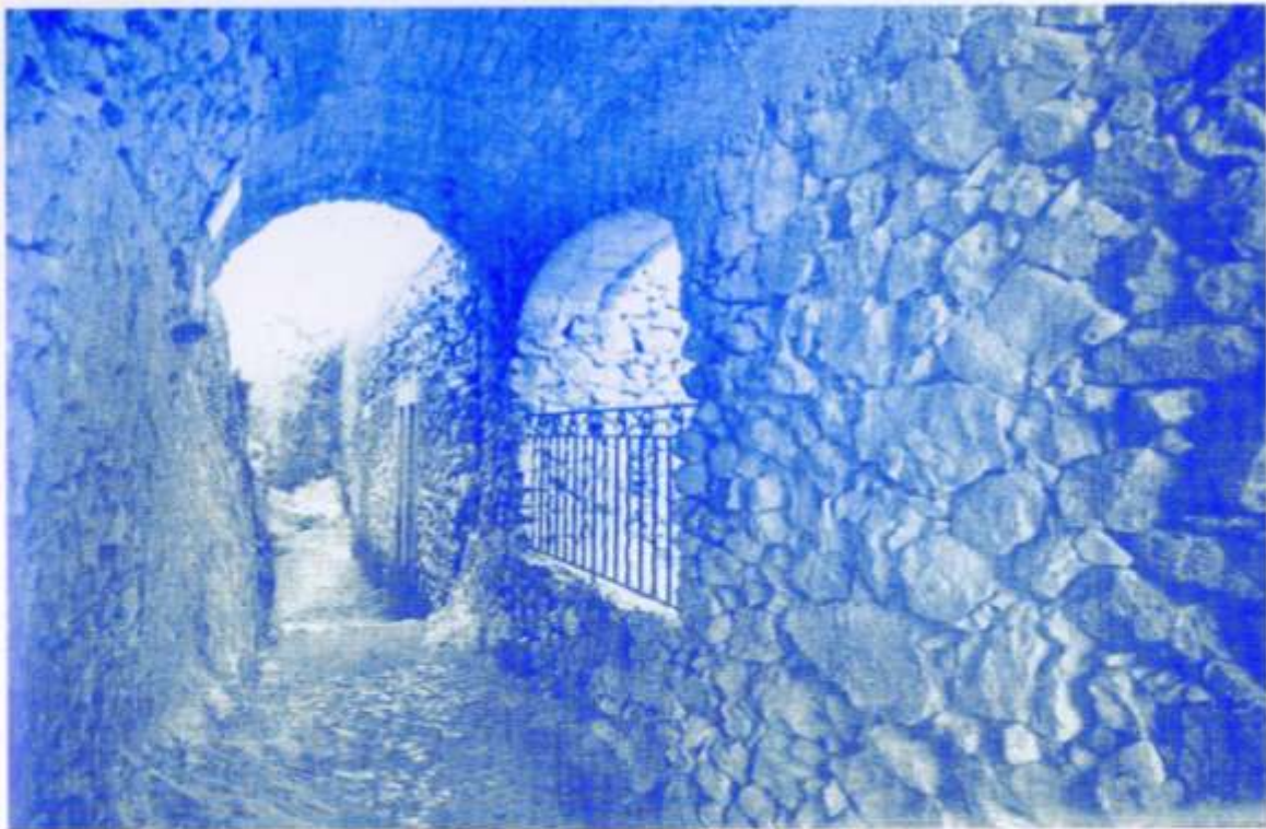
C'est par cette galerie couverte que jadis les Moines se rendaient du Monastère à la Chapelle
