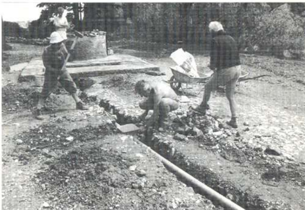
Le même groupe au travail remise en état de l'alimentation de la citerne (14 juin 1989)
