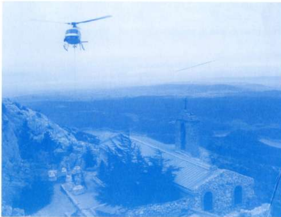
Héliportage des matériaux pour les travaux du porche.
