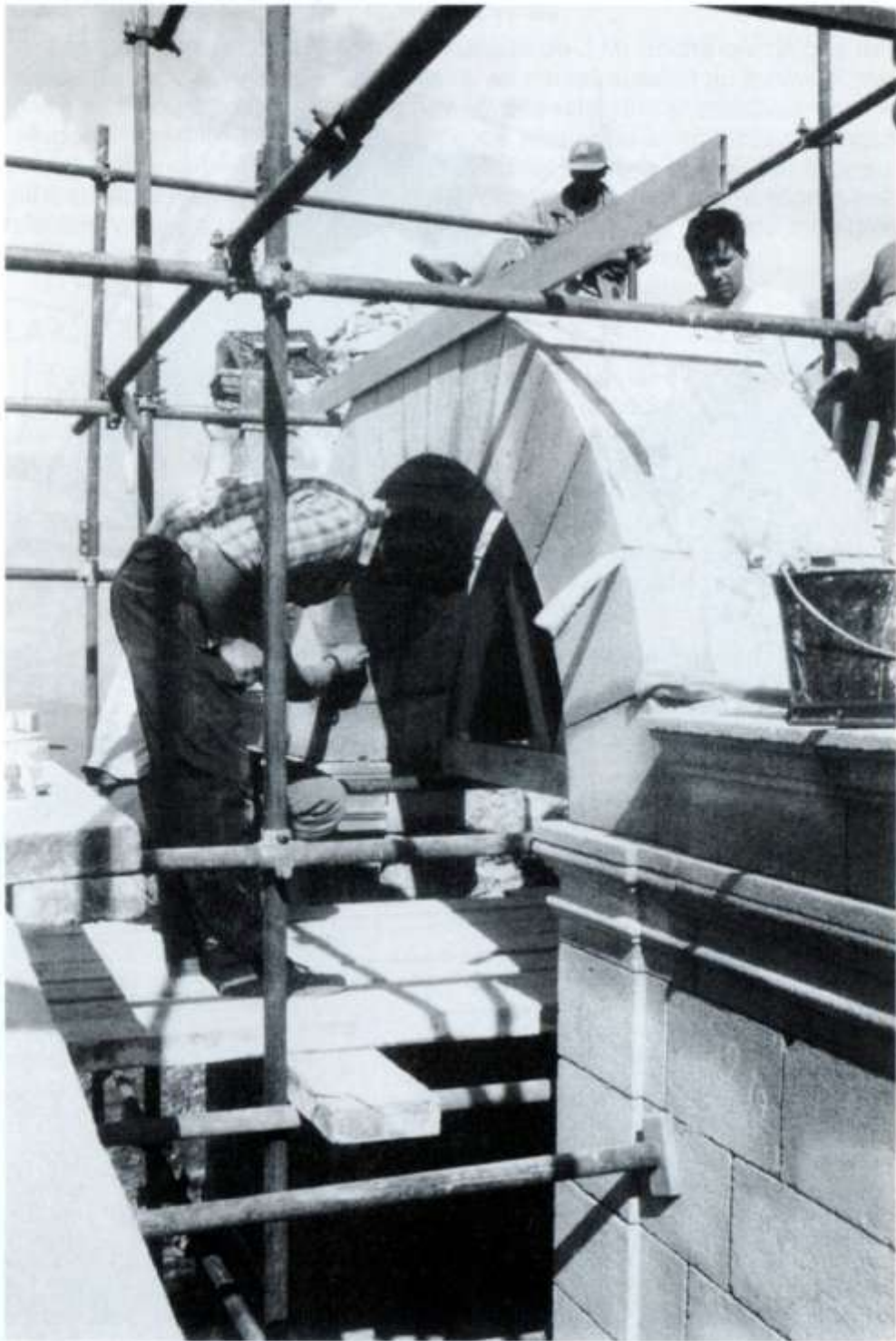
Travaux du porche (Mai 1991)
