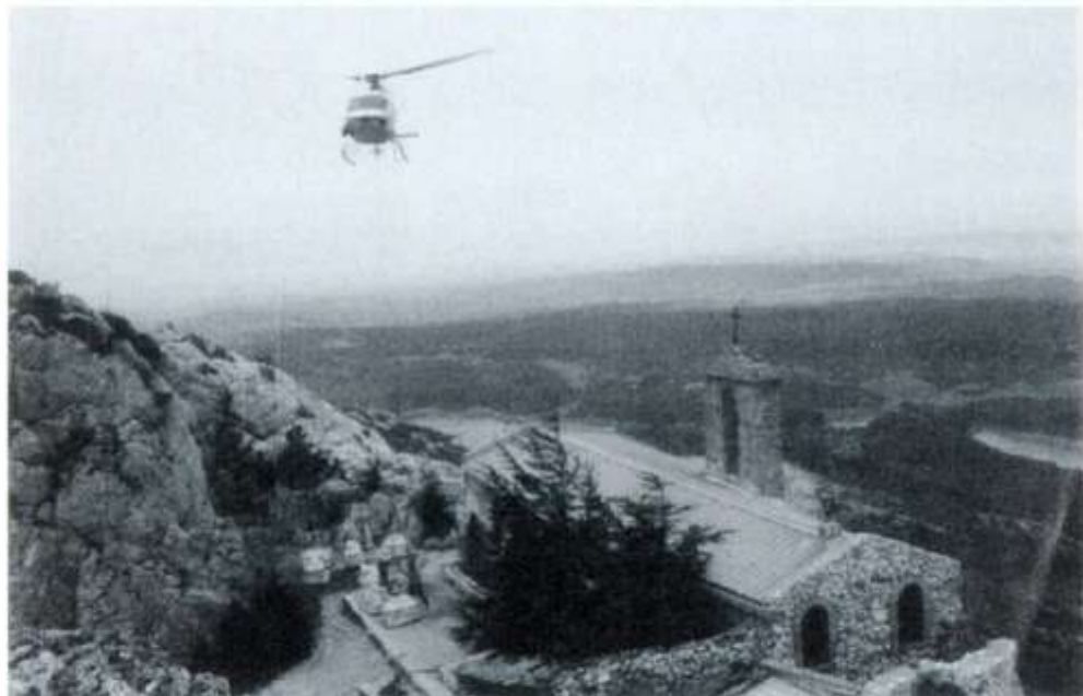
Héliportage pour les travaux du porche (Mai 91)
