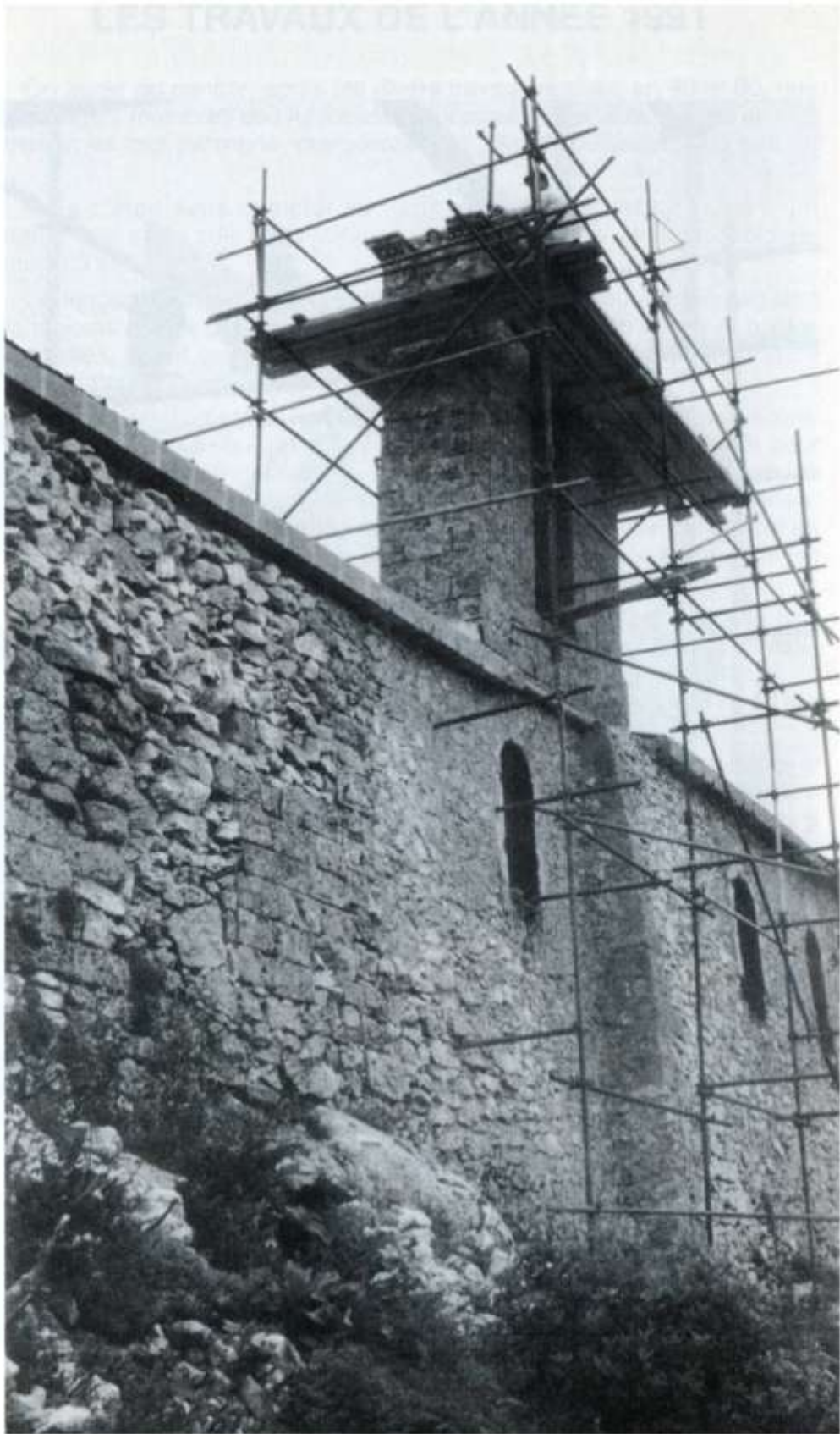
Travaux du clocher en mai 1991
