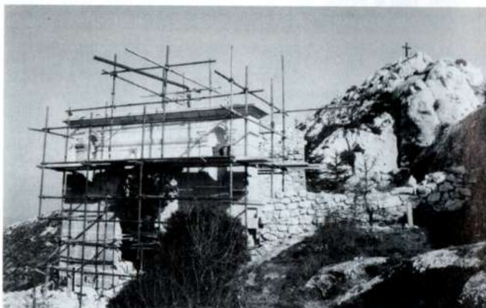
Travaux de réfection du porche (Mai 1991
