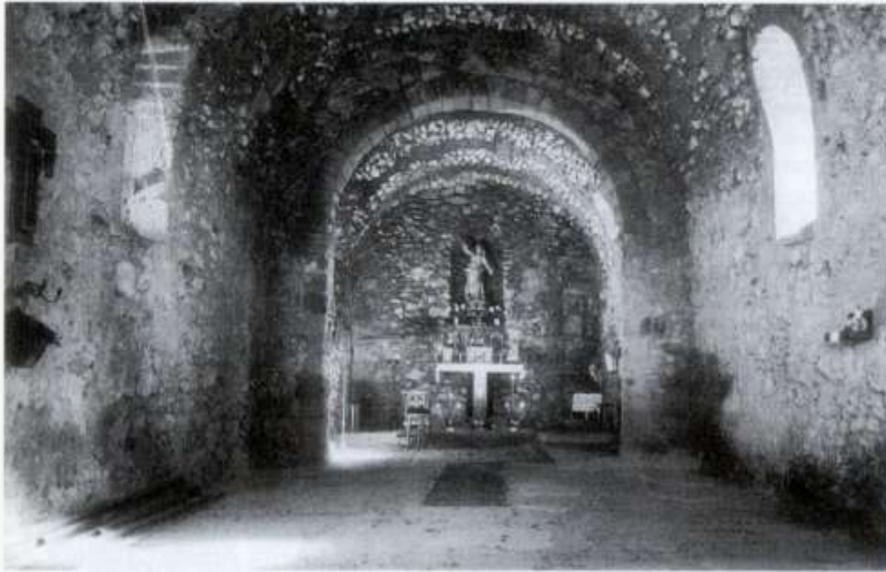
La chapelle avant sa réhabilitation intérieure.
