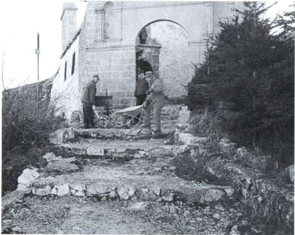
Construction de marches et murets devant le porche. (Photo E. Décanis)
