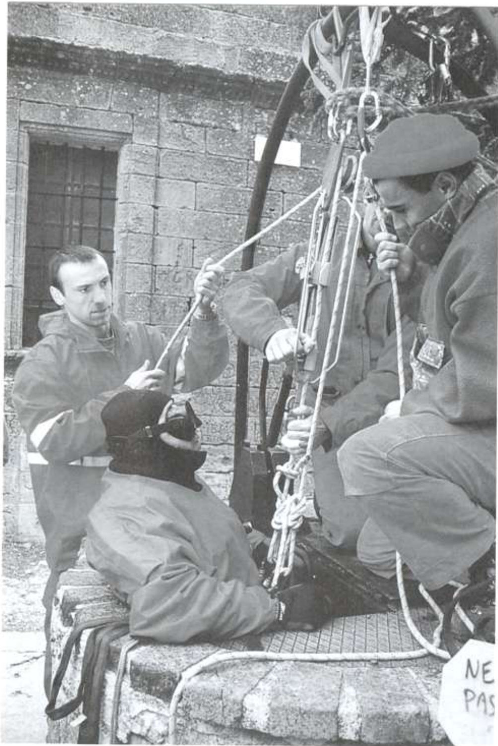
Contrôle de l'état intérieur du puits par l'équipe des pompiers plongeurs. (Photo J. Cathala)
