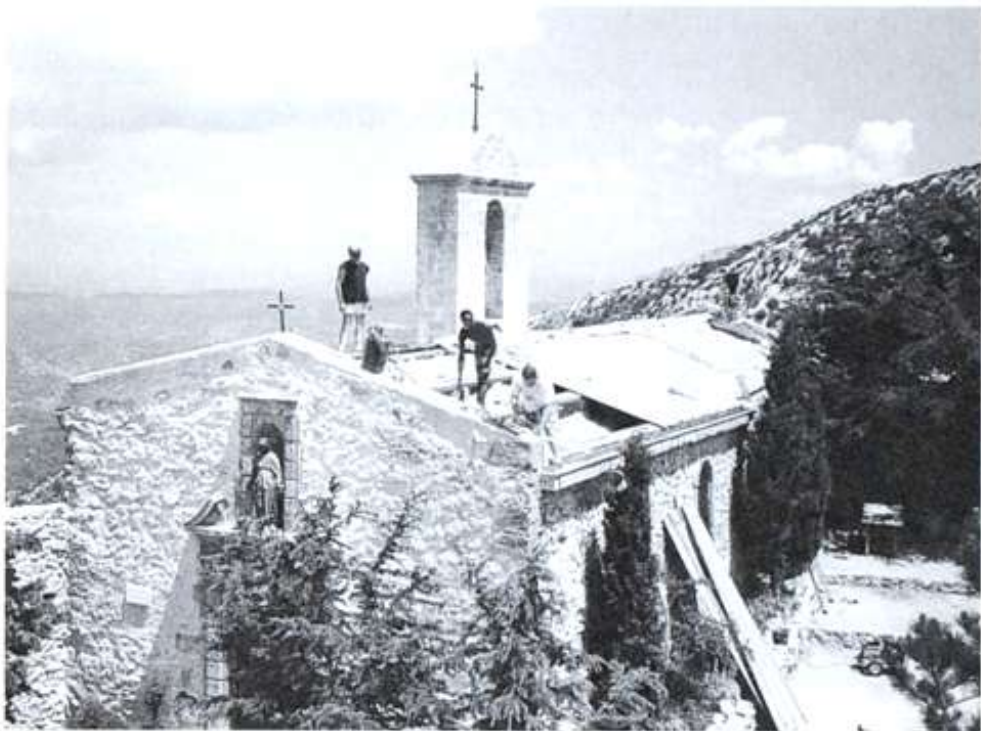
Chantier toiture chapelle. (Photo E. Décanis)
