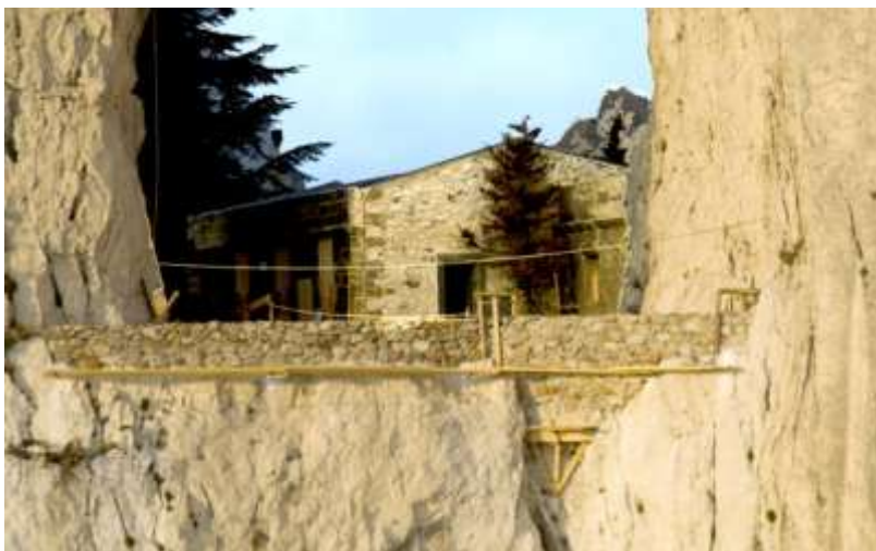
Le parapet de la brèche en construction (Photo Georges Flayols)
