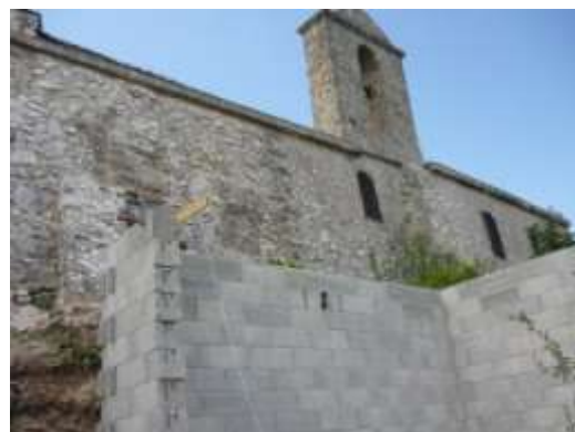
Doublage des murs en pierres sèches
