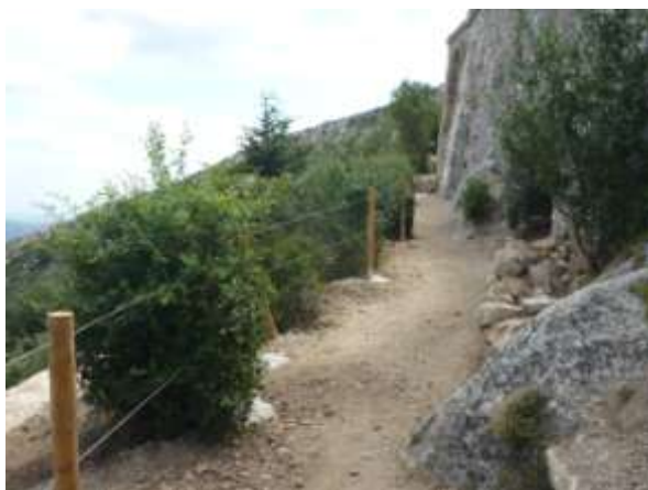
Finition du GR9 au Nord de la chapelle
