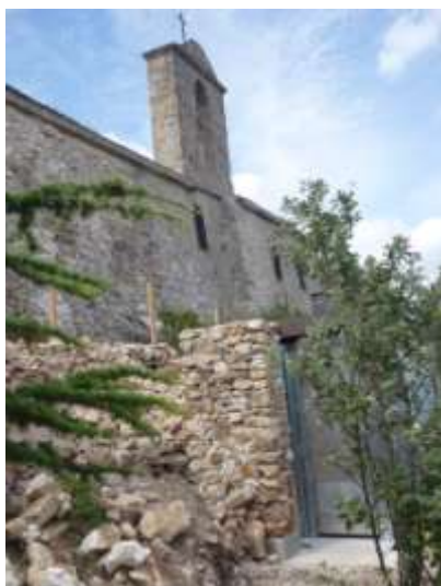
Doublage des murs en pierres sèches
