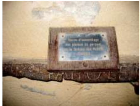
Barre d'assemblage des pierres du parapet
