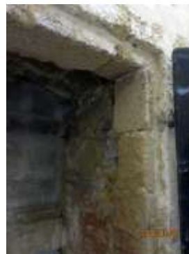
Feuillure de l'encadrement
