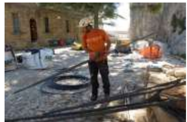
Préparation des barres d'ancrage
