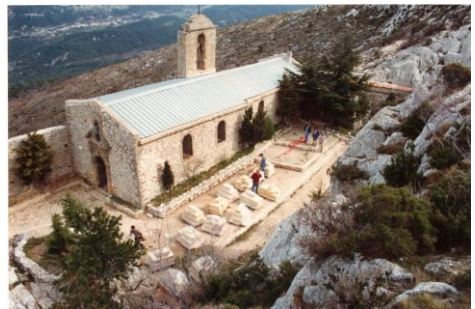
Impressionnant dépôt de pierres taillées pour la réfection du porche
