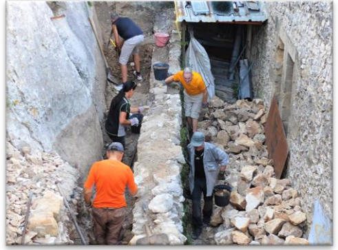
Creusement de la tranchée du cloître, 2016
