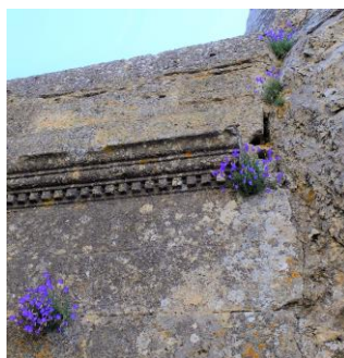
... la façade du local Elzéar
