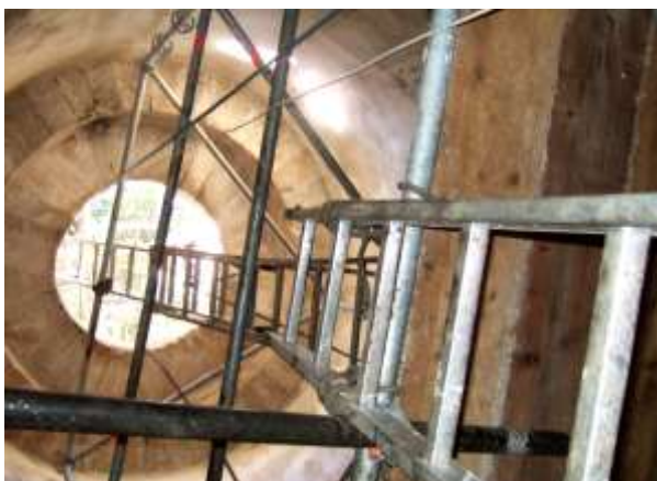
Intérieur de la citerne en pierre de taille (photo prise pendant les travaux en 2009)
