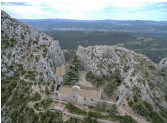
Le Prieuré tel qu'il sera après restauration des toitures
