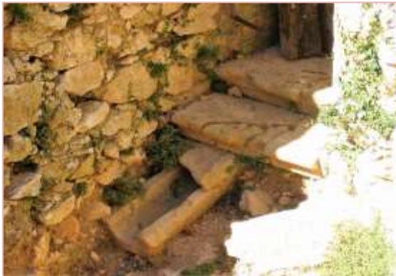
Canalisation sous l'escalier
