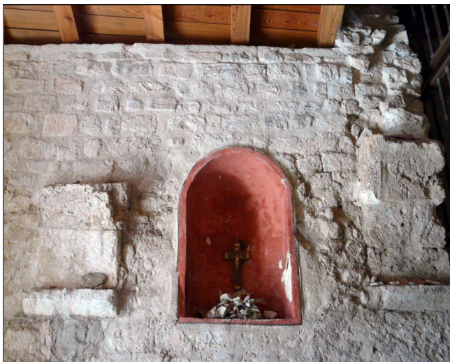
Fig. 7 : Dans le vestibule, les vestiges des arcs supportant l'ancienne voûte. A droite, une grille en fer défend l'accès à la nef.
