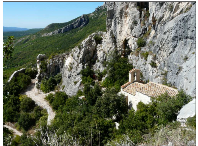
Fig. 4 : La chapelle a cherché un abri illusoire, se blottissant au pied des falaises qui l'ont détruite!
