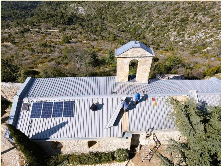
Avril 2021, des bacs acier sont déboulonnés pour évaluer le bon état de la sous-toiture
