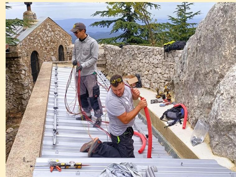
Les raccordements électriques aux panneaux sont préparés, les panneaux sont transférés puis installés un par un.
