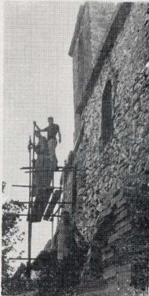
L'échafaudage contre la façade Nord de la chapelle
