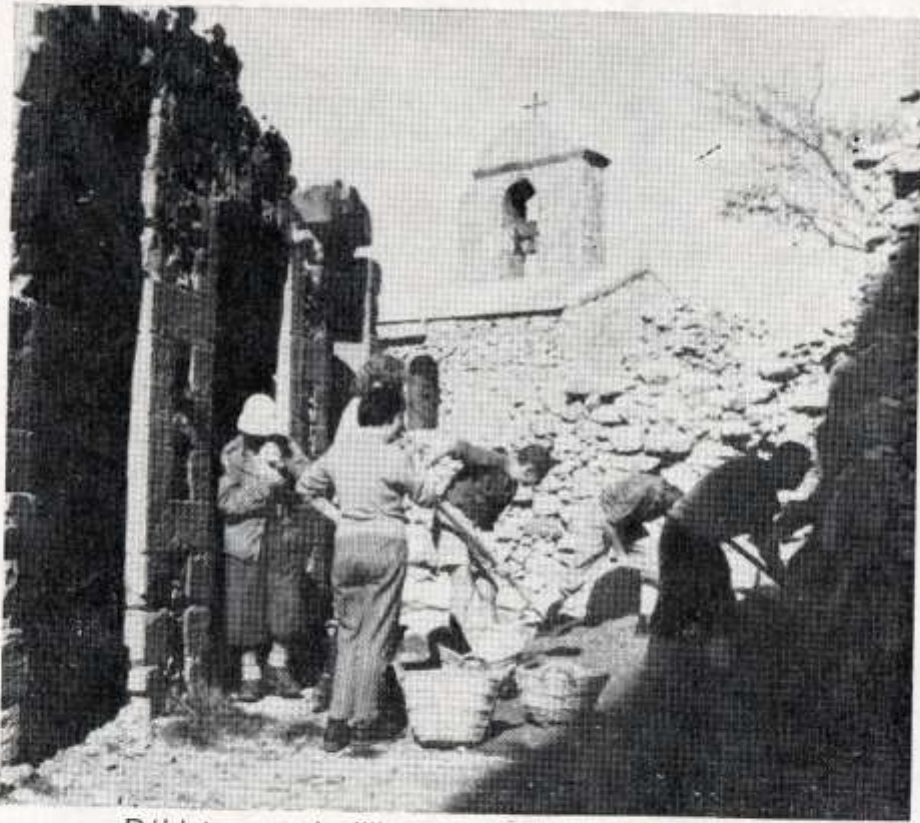
Déblaiement de "l'intérieur" Au fond le clocher
