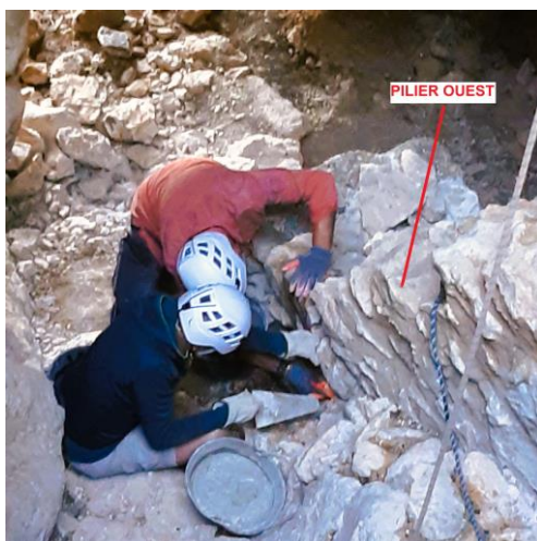
Juillet 2024, renforcement du pilier instable
