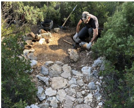
Empierrement d'un virage sur le sentier Imoucha
