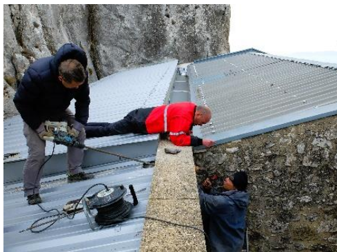
Février 2024, creusement de la saignée et perçage
