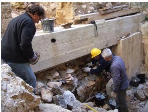
2010, travaux de consolidation sous la poutre
