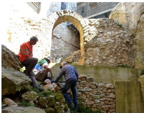
2014, poursuite de la maçonnerie du mur sous la poutre
