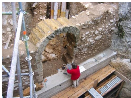
Fin 2008, en gris la poutre de soutènement
