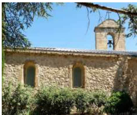
Façade sud de la chapelle
