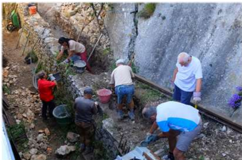
2016, terrassement avant la reconstruction du cloître
