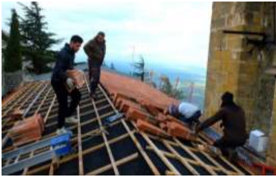
Les couvreurs œuvrent sur le toit de la chapelle
