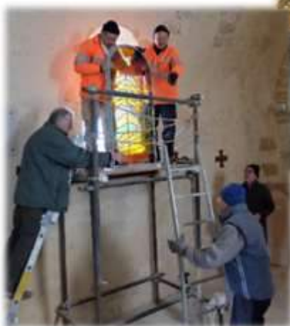
2018, installation des vitraux
