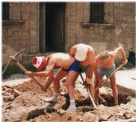
1989, réfection des canalisations
