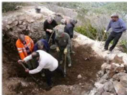
2009, creusement pour loger les futures toilettes
