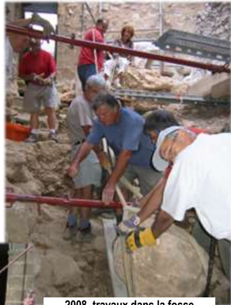
2008, travaux dans la fosse
