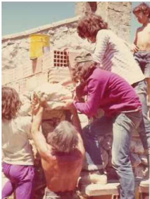
1974, construction du logis
