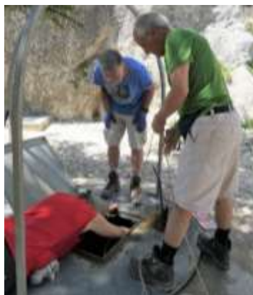
Juin 2019, Jean-Yves Chauveau, Philippe Fortin et Sauveur participent à l'installation de la pompe immergée
