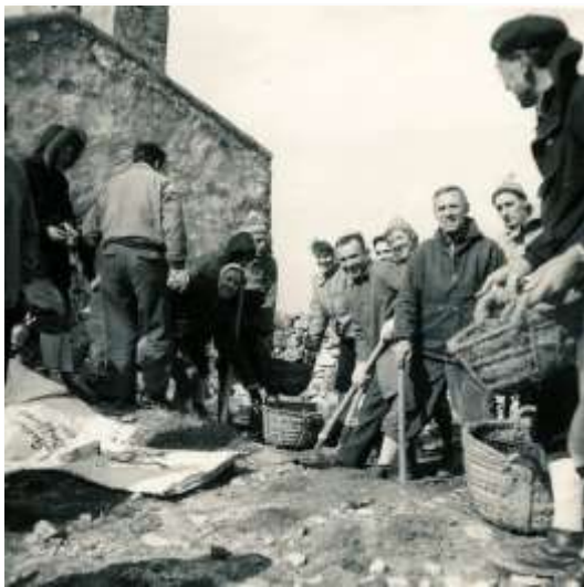
1957, déblaiement de la sacristie avec des couffins
