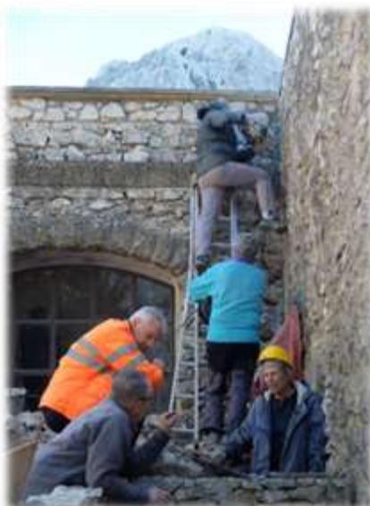
2024, travaux préparatoires à l'installations des panneaux solaires
