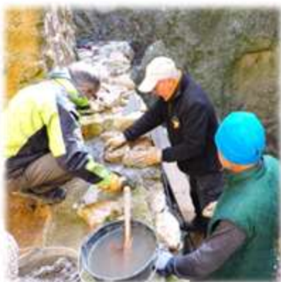
2025, maçonnerie dans l'aven
