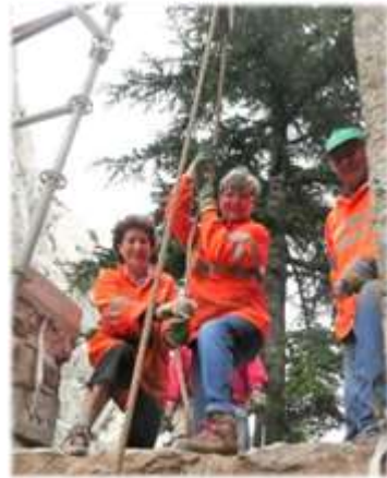
2008, déblaiement de la fosse
