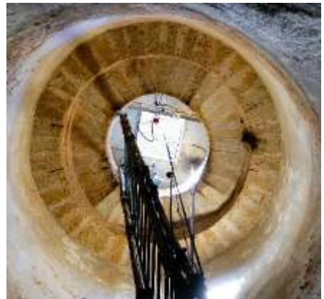
Vue en contre-plongée de la citerne
