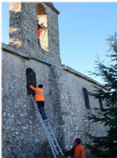
2016, réfection des baies nord de la chapelle
