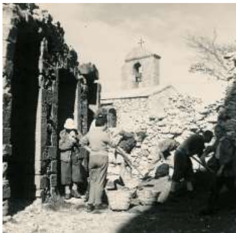
1958, enlèvement des gravats dans le monastère
