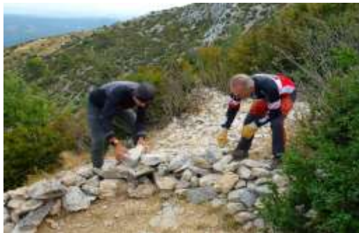
Réfection des murets démolis
