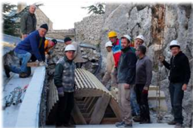
2017, mise en place du coffrage (vau) de la voûte du cloître
