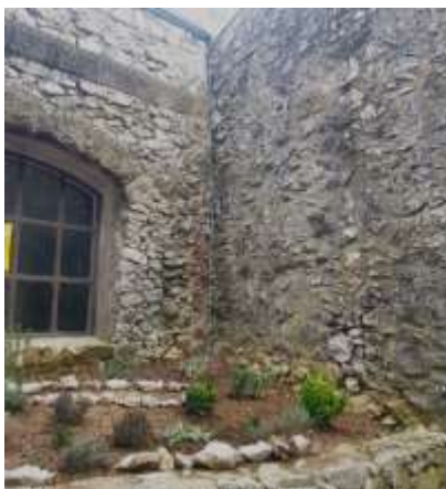
Après les travaux, l'angle avec le jardin, la corniche et la bande plate
