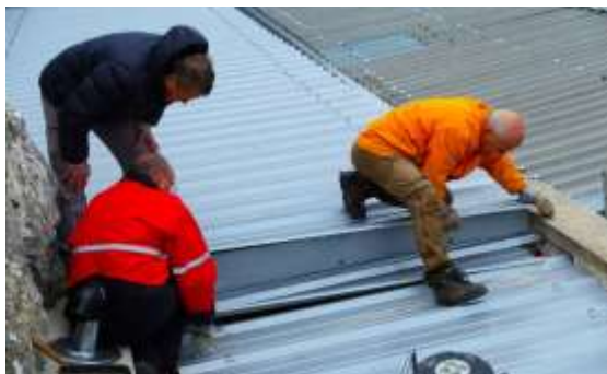
Le conduit coudé sera bientôt posé
