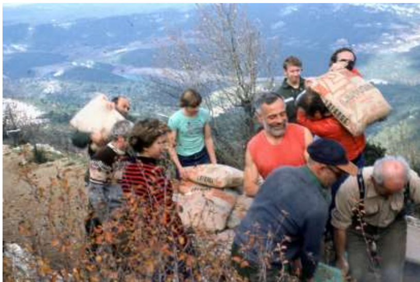
1980, transport de sacs de ciment
