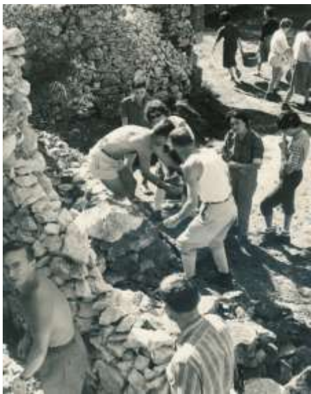
1961, renforcement du petit contrefort du cloître
