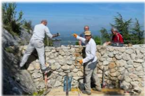
2019, reconstruction du mur du porche
