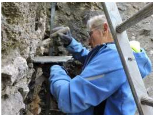
Retouche sur les joints
